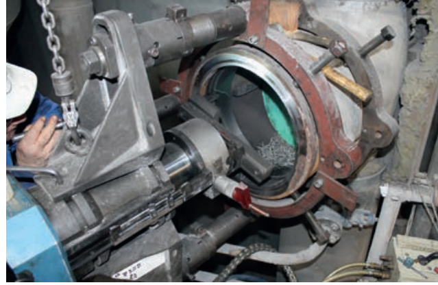
Mobile Bearbeitung: Andrehen einer Schweißnahtfase als Vorbereitung zum Einschweißen einer Armatur
