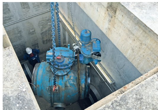
Die Borsig-Armaturen mussten aus einem circa acht Meter tiefen Schacht aus- und nach Revision wieder eingebaut werden
